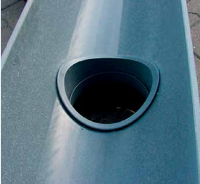
Vue intérieure après hydrocurage
